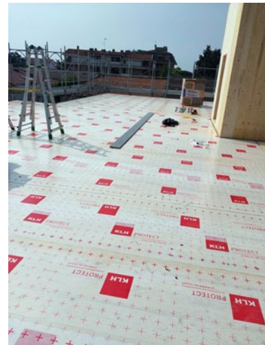
Abb. 13: KLH Protect auf der Baustelle
