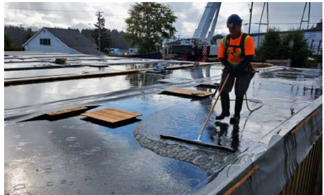
Abb. 29: Entfernen von stehendem Wasser
