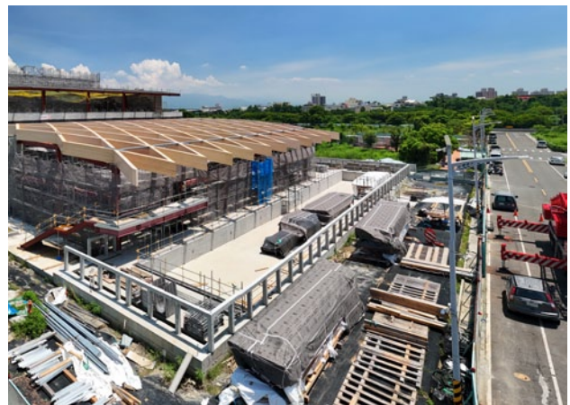
Abb. 7: Paketlagerung auf der Baustelle
