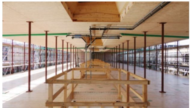
Abb. 28: Gesicherte und abgedeckte Öffnungen während der Bauphase
