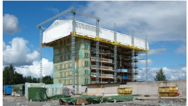
Abb. 15: Temporäres Baustellendach, Berlin
