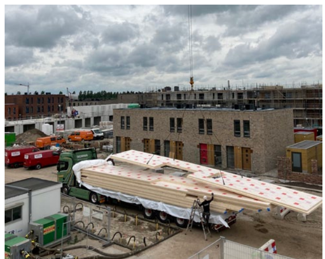
Abb. 2: Verladung von Deckenelementen
