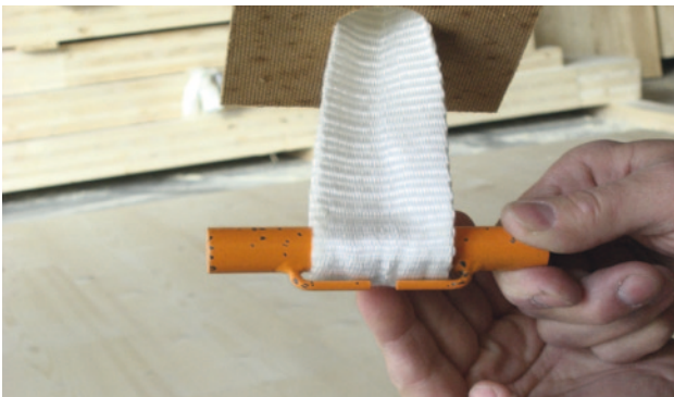
3. Poner el perno con la pinza de retención hacia abajo y colocarlo adecuadamente
