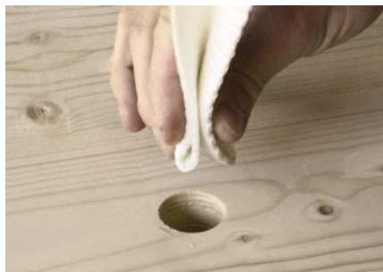
1. Poner el lazo de elevación en el taladro
