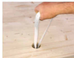
2. Situación de elevación con el sistema VLS S incorporado
