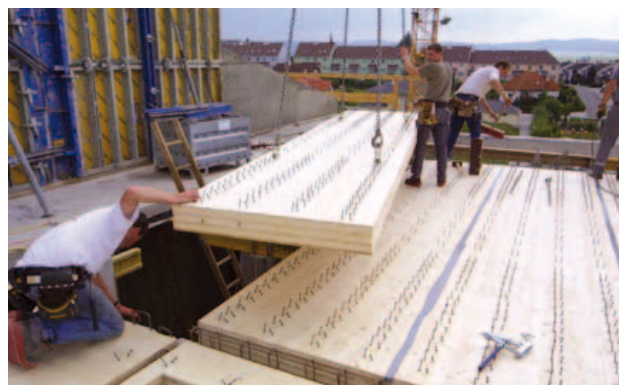
Montage d'éléments avec connecteurs à vis sur le chantier (www.ancon.at)
