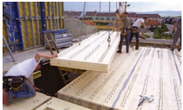
Montage d'éléments avec connecteurs à vis sur le chantier (www.ancon.at)
