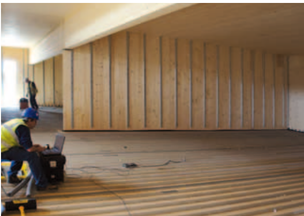
Préparation des éléments KLH®-bois-béton en vue de l'application du béton sur chantier (TimCrete © Ramboll)
