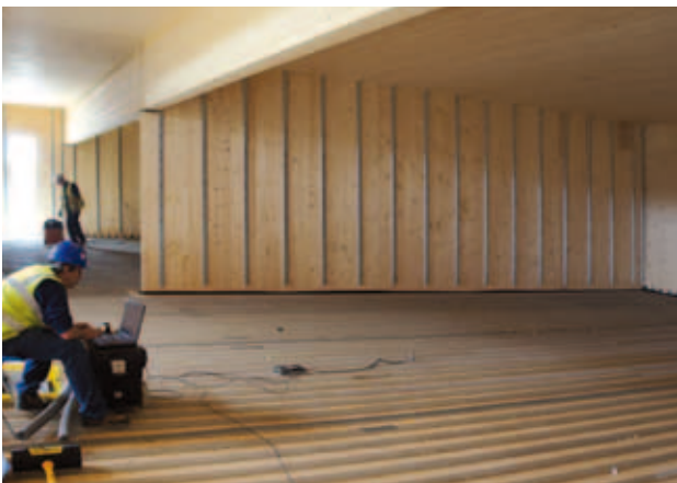
Preparación de elementos de unión madera-hormigón de KLH® para la aplicación de la capa de hormigón sobrepuesta en la obra (TimCrete © Ramboll)
