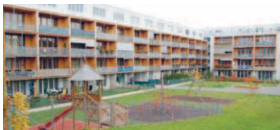
Complesso residenziale "Spöttelgasse", Vienna
