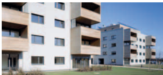
Casa passiva "Am Mühlweg", Vienna
