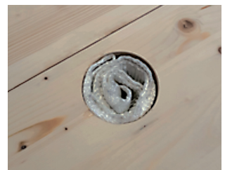
3. Transportsituation mit eingewickelter Schleufe im Bohrloch
