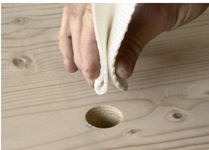
1. Hebeschleufe in die Bohrung einsetzen
