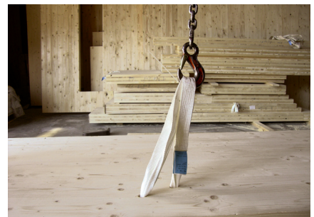
3. Hebesituation mit eingebautem System FD
