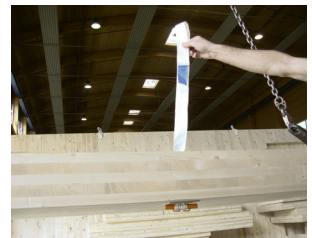
4. Hebesituation mit eingebautem System FB
