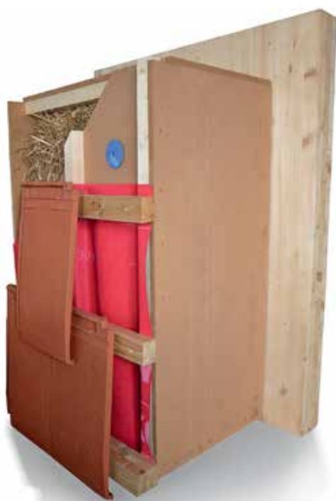
Prinzip des Aussenwandaufbaus Foto: zvg
