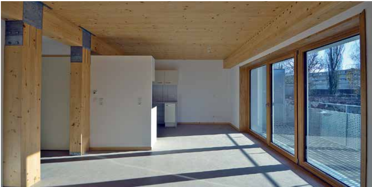
Raumeindruck mit sichtbarem Holz: Stützen und Unterzüge erlauben offene Räume.
