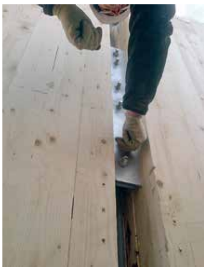
Eingeschlitzte Bleche in den Aussenwänden spannen die drei Gebäudeblöcke in den Vertikalfugen über geschweisste Bolzen zusammen.
