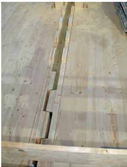
Die Doppel-Querwände mit Dämmlage erhielten in den Randbereichen zusätzliche Verzahnungen in Wandebene. Sie nehmen Horizontalkräfte ebenfalls über Druckkontakt auf.
