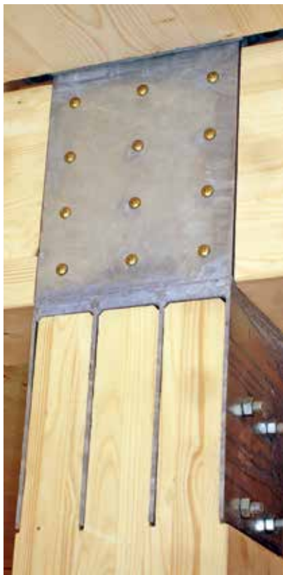
Lastdurchleitende Stahlknoten verhindern eine Querpressung auf Decken und Unterzüge durch die Stützen.
