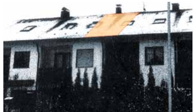
Abb. 5: Über einen laufenden Meter Wärmebrücke am Mauerwerkskopf geht genauso viel Wärme verloren wie über drei Quadratmeter ungestörte Dachfläche. Schwächen im Dachbereich lassen sich bei Schneelage wie in diesem Bild sehr einfach auch optisch erkennen am abgetauten Schnee
